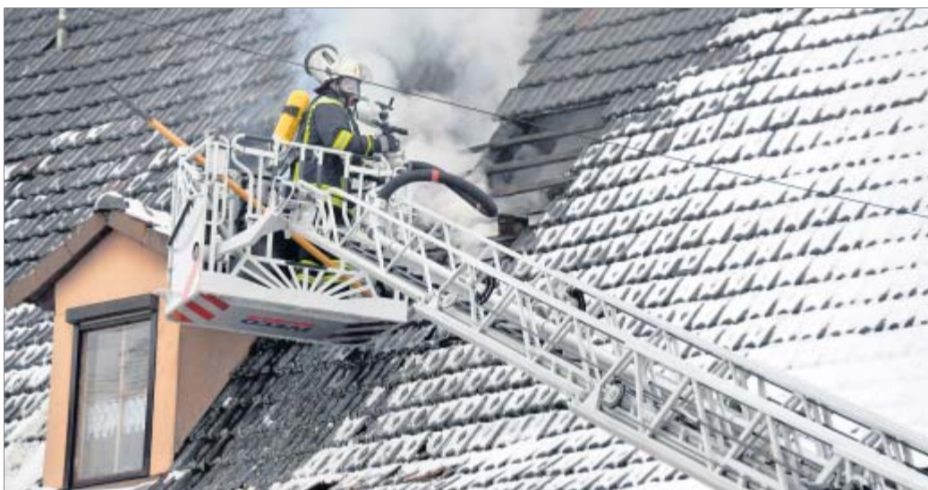
Von außen und von innen wurde der Brandherd bekämpft.
