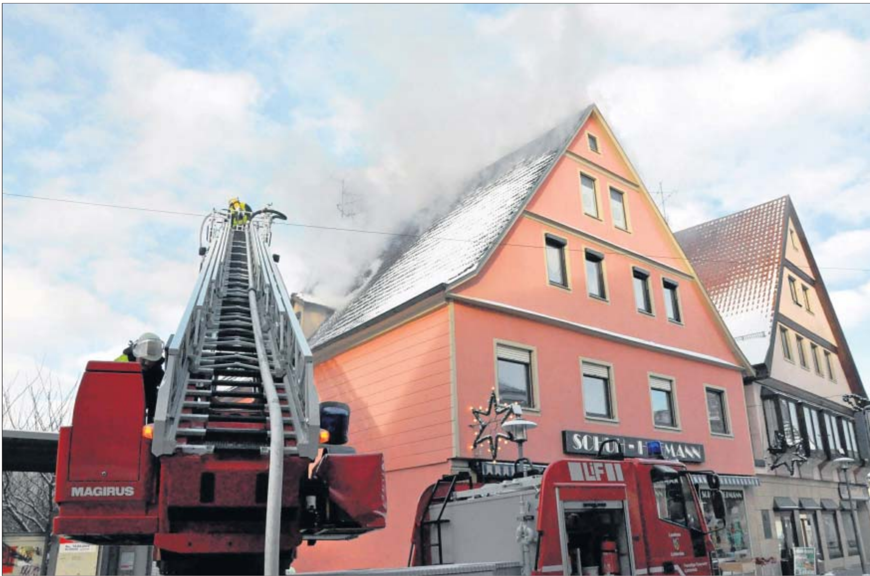
Dicke Rauschschwaden quollen aus dem Dachstuhl des Wohn- und Geschäftshauses hinter dem Lichtenfelser Rathaus.
